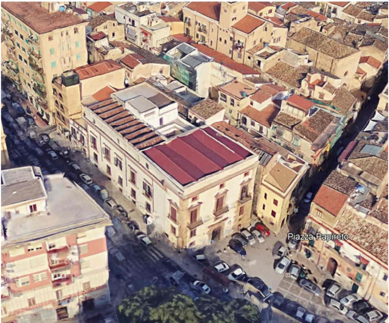
Figura 3 - Vista dall'alto dell'edificio
